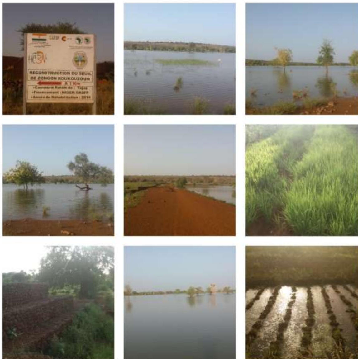
Photo : Seuil d'épandage de Zangon Roukouzoum
