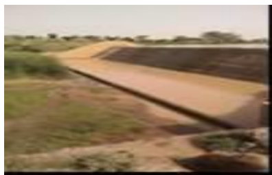
Photo 2 : Digue du barrage de Kassama en juillet 2015
