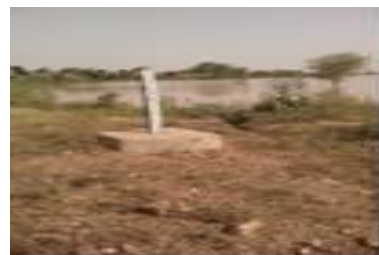
Photo 3 : Echelle de crue pour la surveillance des niveaux dans le barrage
