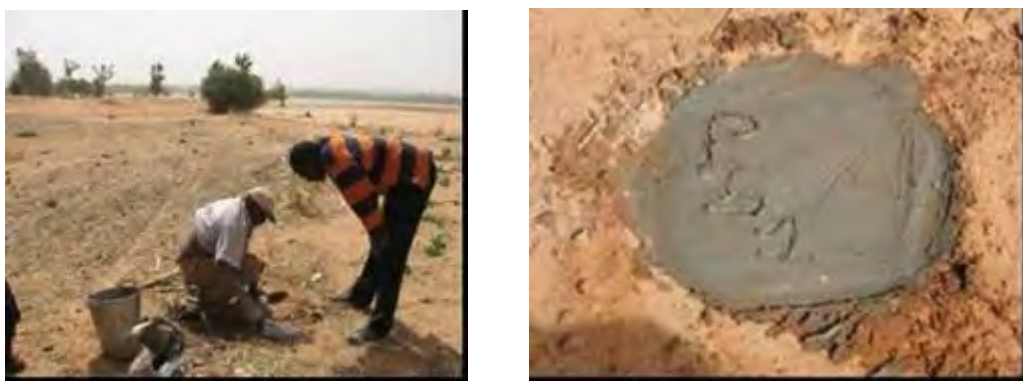
Photo 14: Matérialisation d'une borne et Borne Numéro P51 sur le kori Boubon
