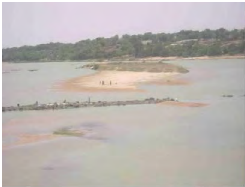
Photo 97: Digue ensablée construite en 1987 en amont du pont Kennedy de Niamey (avril 2009).
