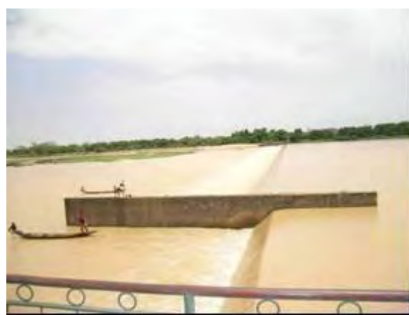
Photo 106: Seuil – barrage de retenue de Goudel
