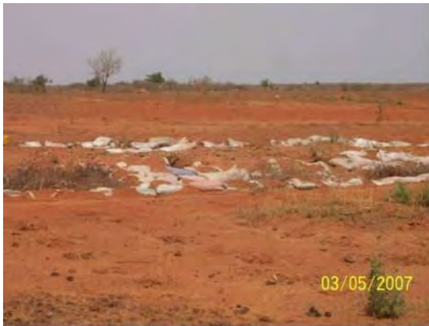
Photo 137: Lutte contre le ravinement parallèle avec des sacs de sables près Gorou Kirey
