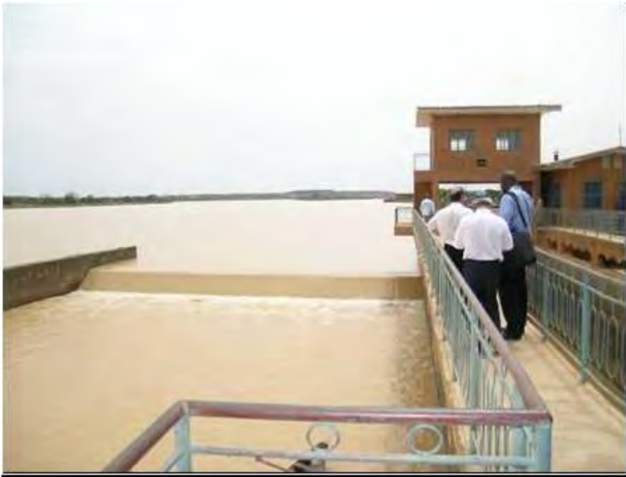
Photo 111: Seuil – barrage de Goudel construit en 1989, près de la station de pompage d'alimentation en eau de Niamey
