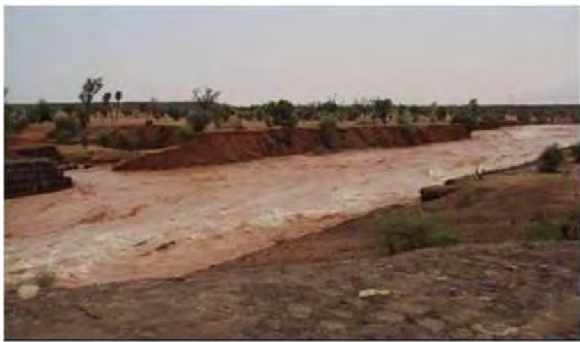
Photo 82: Crue du kori Boubon, au second plan l'apport d'un drain secondaire en amont du pont
