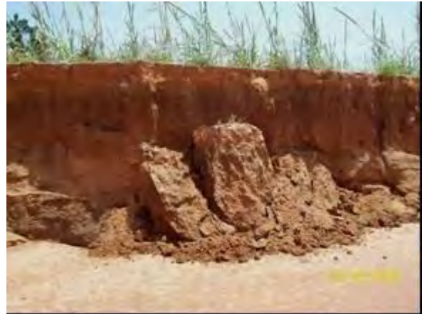
Photo 87: Effondrement de berge sur le kori Boubon en aout 2009
