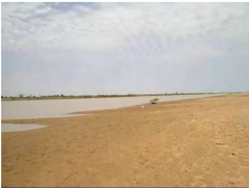
Photo 107: Envasement du seuil –retenue de Goudel en période d'étiage de mai 2009
