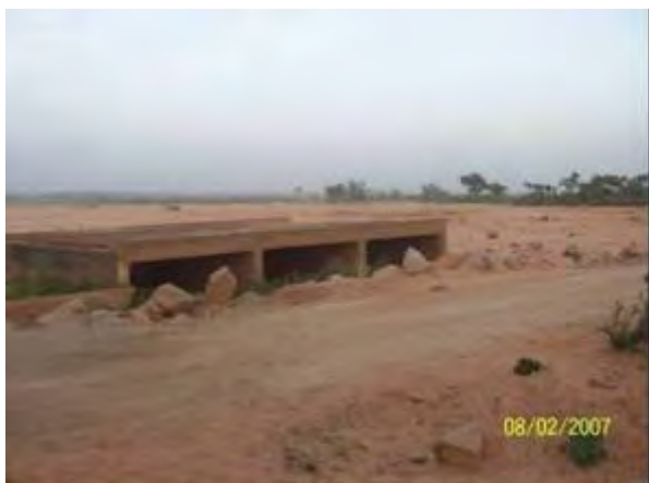
Photo 50: Buses en béton restant du radier détruit par une crue du kori Kourtéré en 1998
