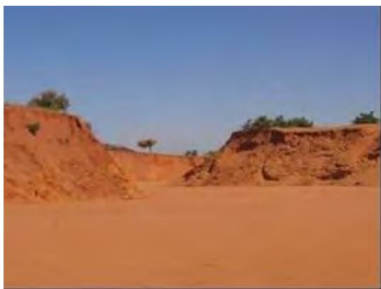
Photo 62: Présence des arbres dans l'axe d'écoulement du kori Hamdalaye à 50 km à l'Est de Niamey en septembre 2009
