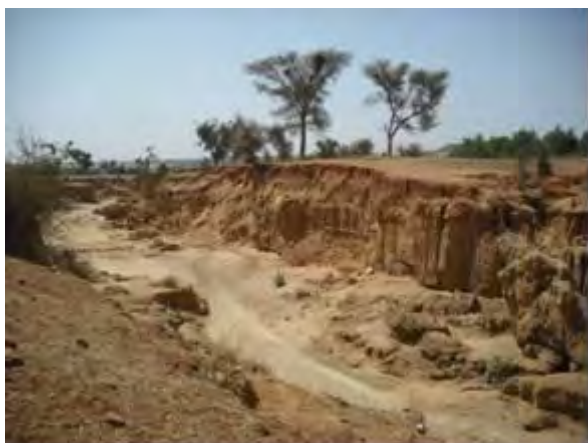
Photo 52: Rupture d'endoréisme du kori Lossa Goungou ; vue vers l'aval
