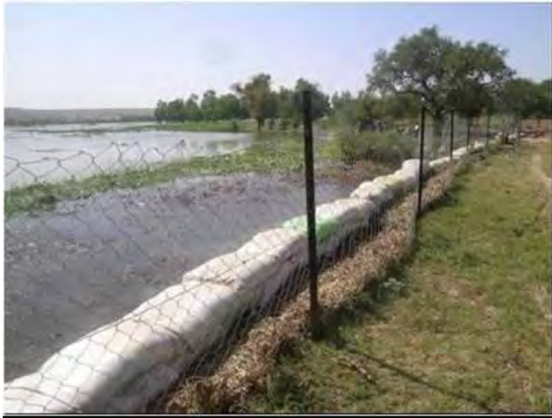
Photo 124: Digue de protection d'un jardin contre la montée des eaux lors de la crue guinéenne du fleuve Niger à Lossagoungou en 2010
