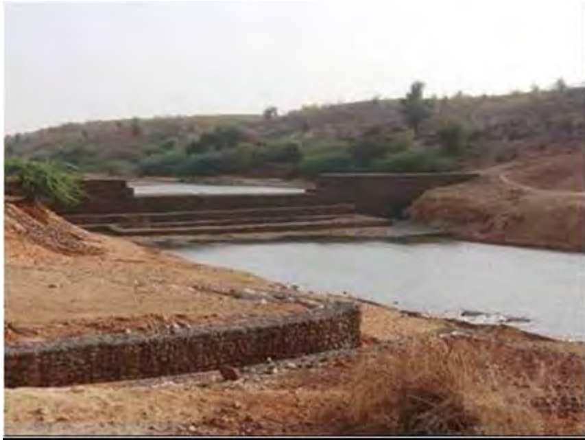
Photo 117: Seuil d'épandage sur le kori Soudouré
