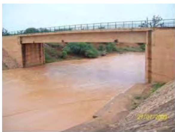
Photo 48: La section d'écoulement du kori Boubon au pont reconstruit en 1998 (pour la troisième fois)
