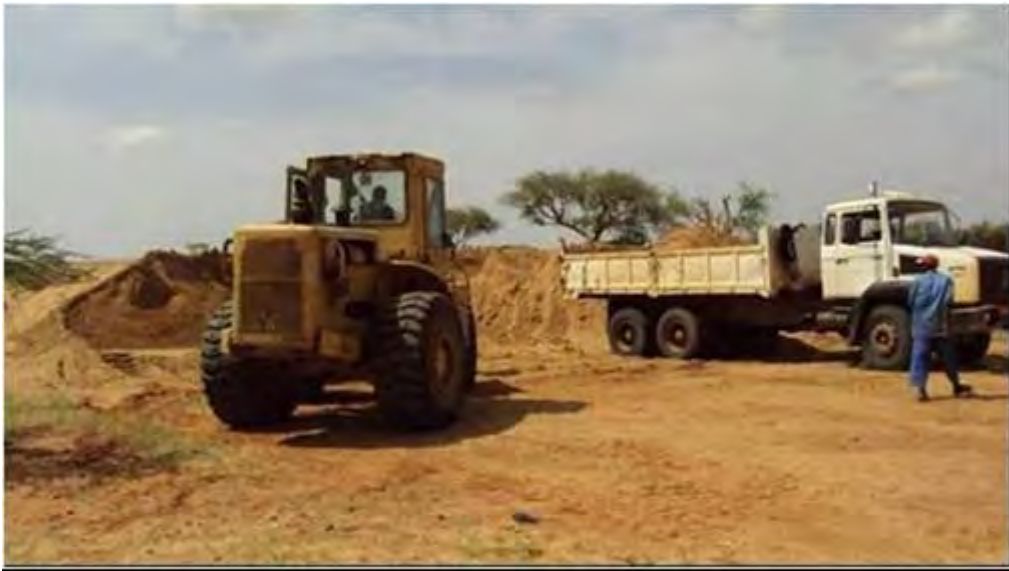
Photo 114: Sable dragué et transporté et réutilisé pour du béton dans des chantiers environnants
