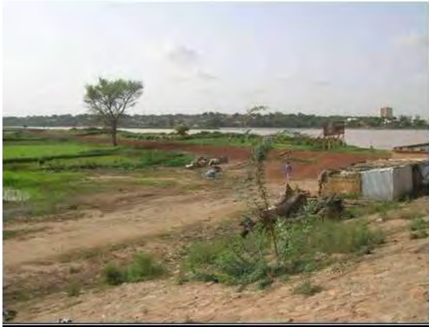
Photo 126: Digue de protection contre l'inondation construite à Niamey après la crue blanche dévastatrice de 2010 du fleuve Niger
