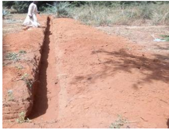
Image 15 : Fouille du réseau secondaire
