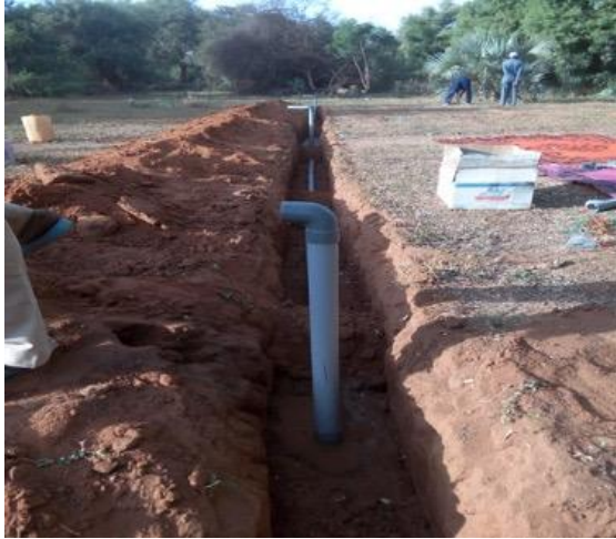
Image 16 : Pose réseau avec 3 bornes
