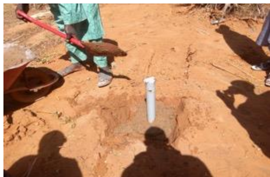
Image 20 : Fixation des bornes (manchons)
