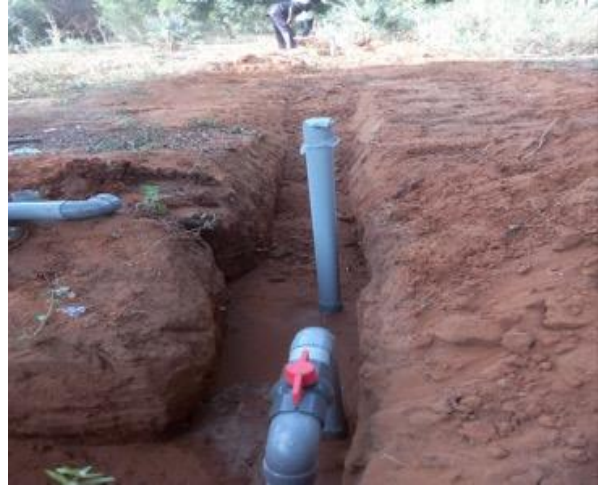
Image 17 : Pose réseau secondaire
