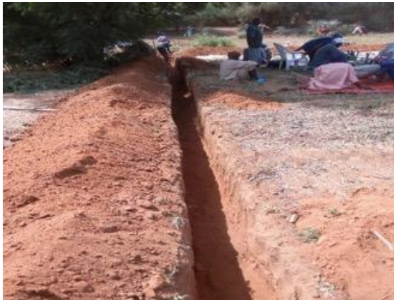
Image 14 : Fouille du réseau principal.
