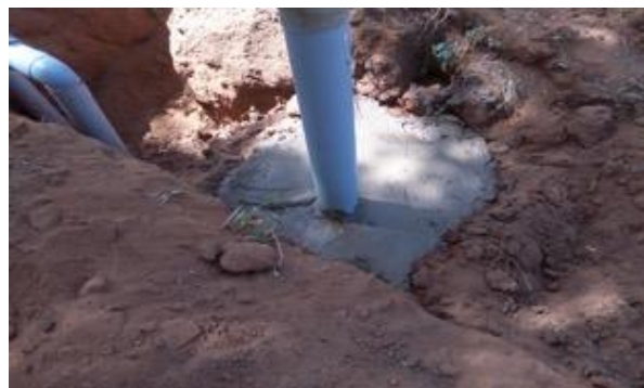
Image 20 : Fixation des bornes (manchons)
