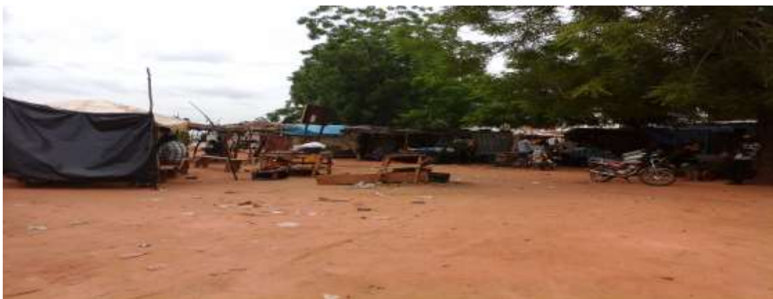
Photo 5 : commerces qui seront impactés par la pose de la conduite en fonte
