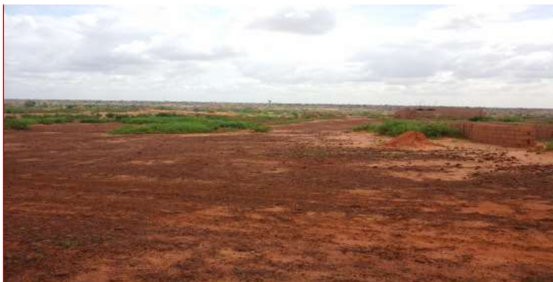
Photo 3 : Site de construction du réservoir (R16) sur la route Filingué
