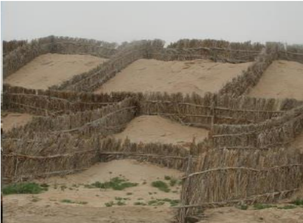
Image 14 : Palissades pour fixation de dunes.
