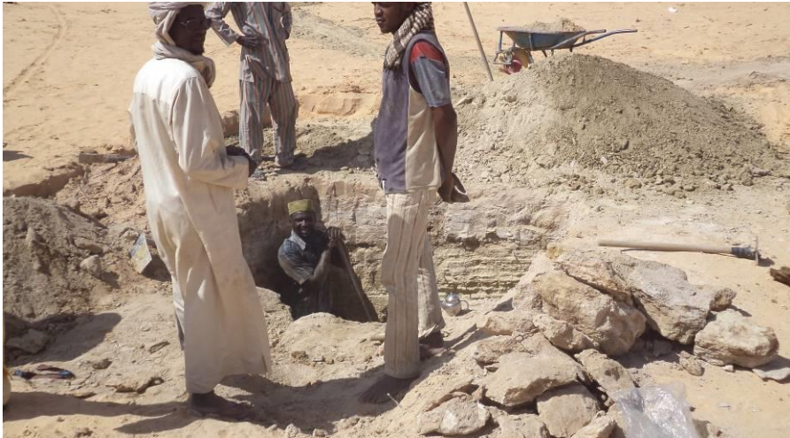
Photo 30 : Fonçage d'un puits à Fachi (beaucoup d'argile)
