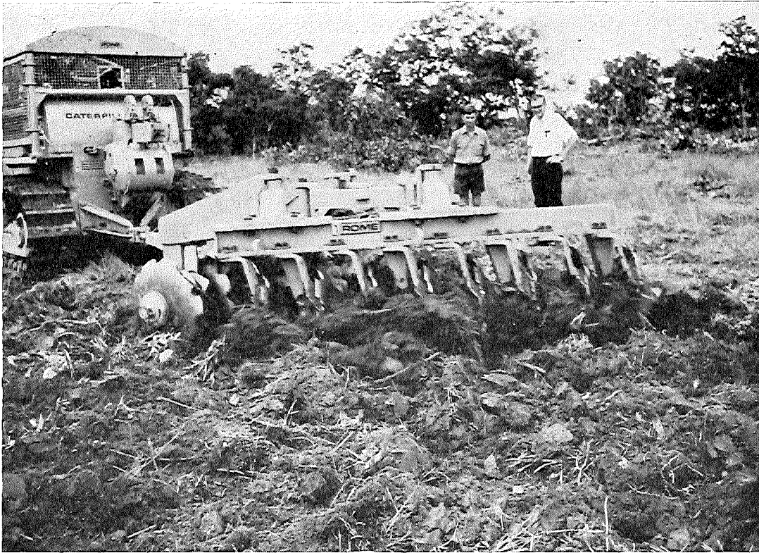
23. Préparation du terrain au Nigéria: défonçage par pulvérisateur lourd déporté attelé à un tracteur à chenilles T.G. Allan
