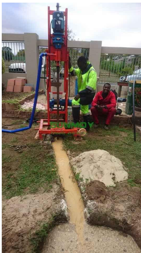
Image 10 : Foration à l'aide d'une tarière thermique sur plateforme mobile
