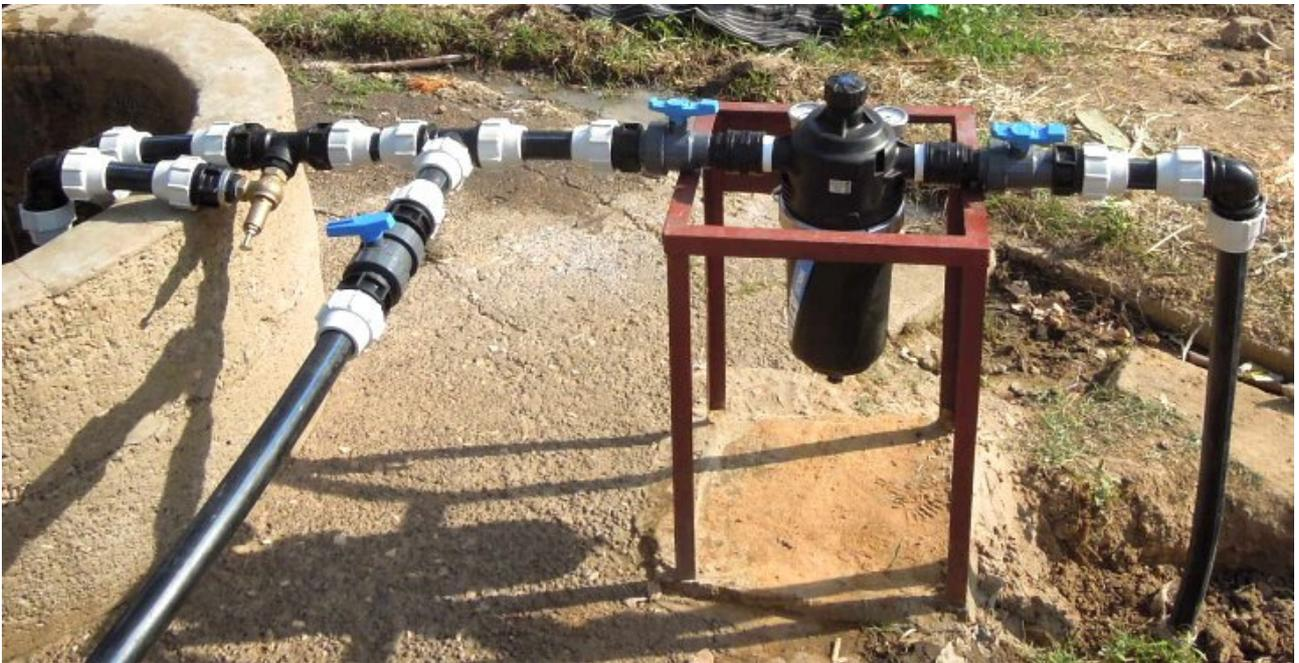
**Figure 11 – Le répartiteur de flux ou l'eau est envoyé dans les 4 secteurs d'irrigation**
