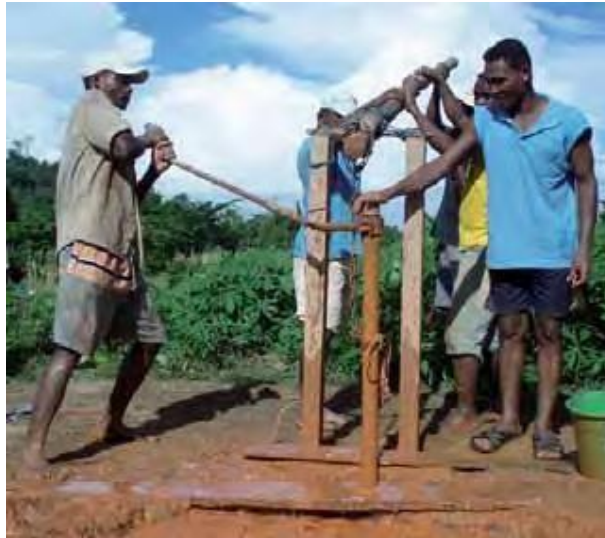
Image 122 : Réalisation d'un forage à la boue
