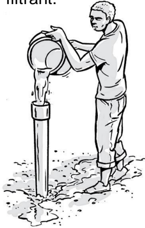
Image 188 : Rincer et nettoyer le forage et la crépine Image 189 : Commencez à verser lentement le massif filtrant
