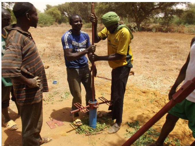
Image 18 : Réalisation d'un forage à la tarière
