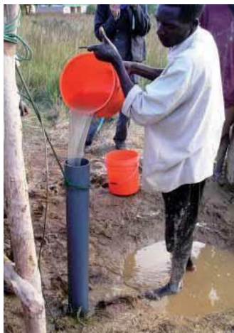
Image 15 : Rinçage du forage à l'eau
