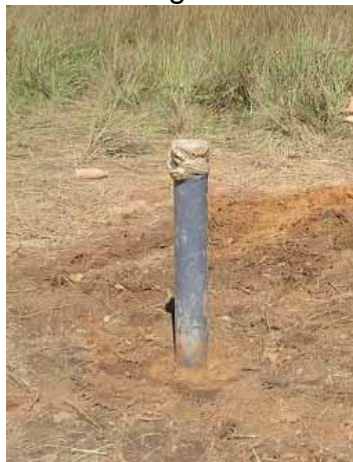
Image 17 : Remblayage de l'espace annulaire
