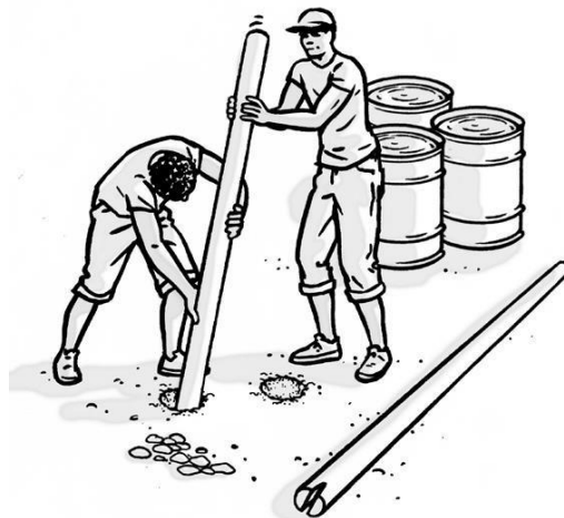
Image 157 : Placez l'un des poteaux dans son trou
