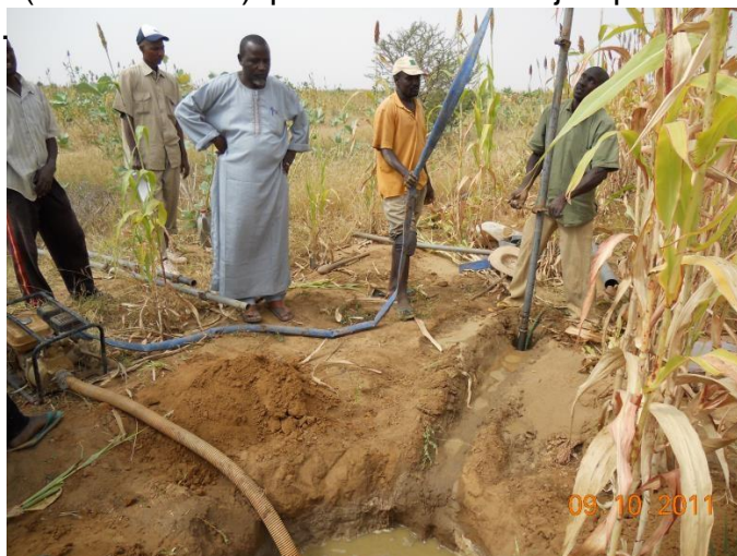
Image 190 : Réalisation d'un forage au lançage à l'eau
