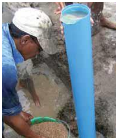
Image 16 : Installation du massif filtrant
