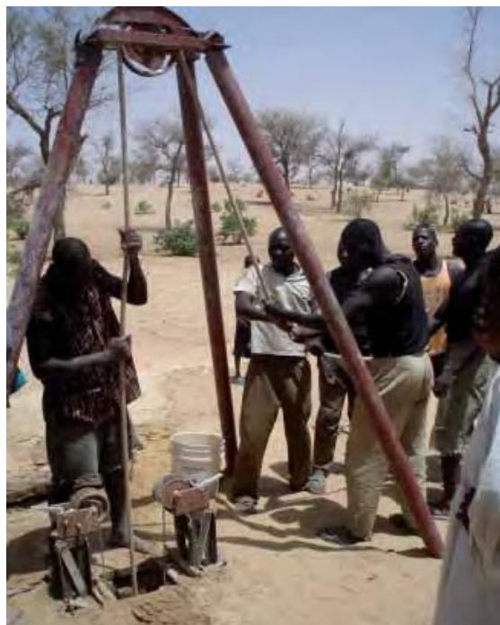
Image 77 : Réalisation d'un forage à la percussion
