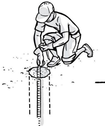
Image 186 : Mesurer la profondeur du trou
