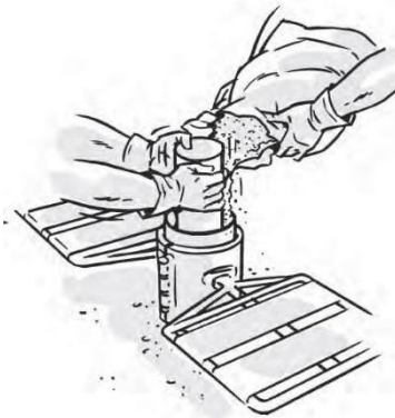
Image 74 : Versez petit à petit du massif filtrant entre et le tuyau d'équipement
