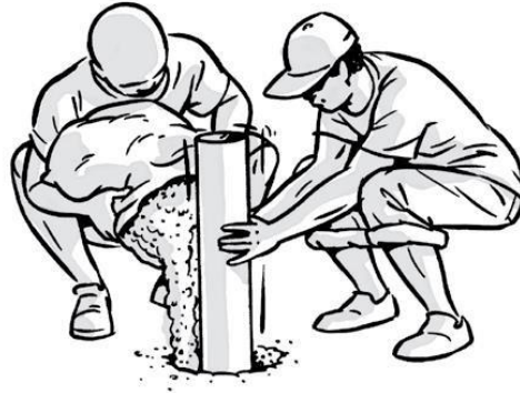
Image 188 : Rincer et nettoyer le forage et la crépine Image 189 : Commencez à verser lentement le massif filtrant
