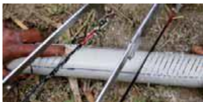
Image 6 : Tuyau crépiné traditionnellement
