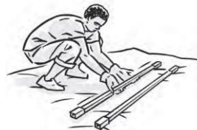
Image 65 : Posez les allonges sur une bâche
